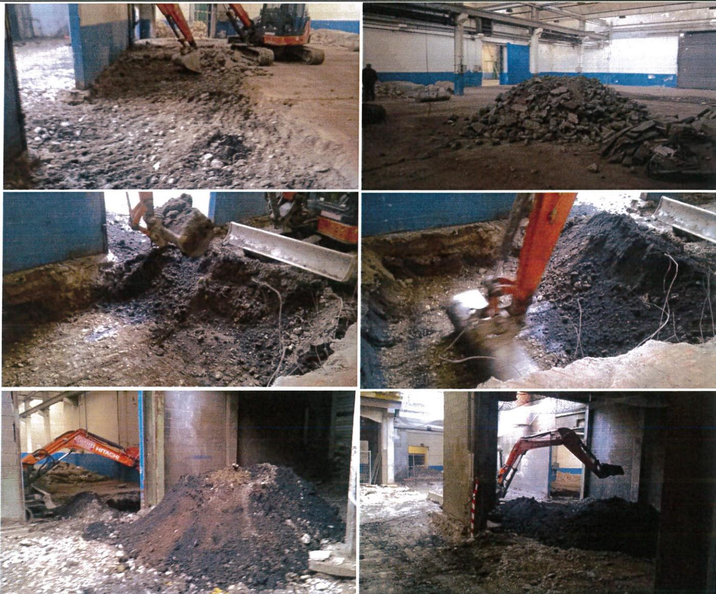
**Démolition de la dalle et mise, stock des bétons et terrassement des terres impactées**
