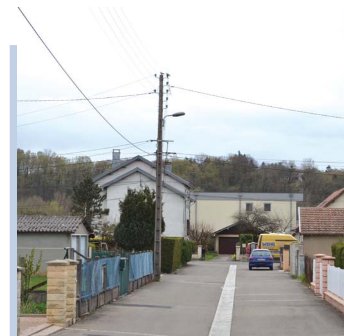
La rue des Courts Champs a déjà été équipée de Leds.
