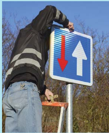
Les panneaux ont dû être remplacés d'urgence par les employés municipaux.
